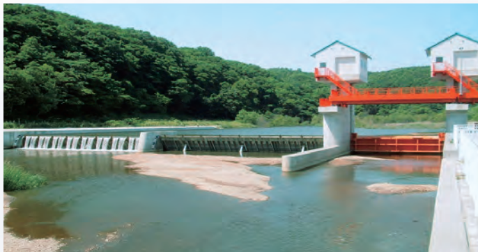
油圧式背面支持式転倒ゲート
